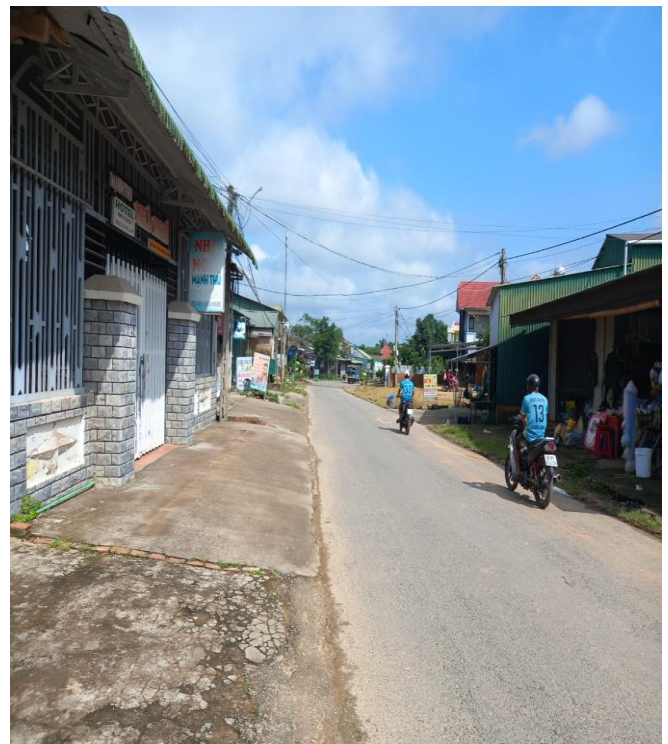
Đường ĐT 722 đoạn trung tâm xã Đạ Tông năm 2024
