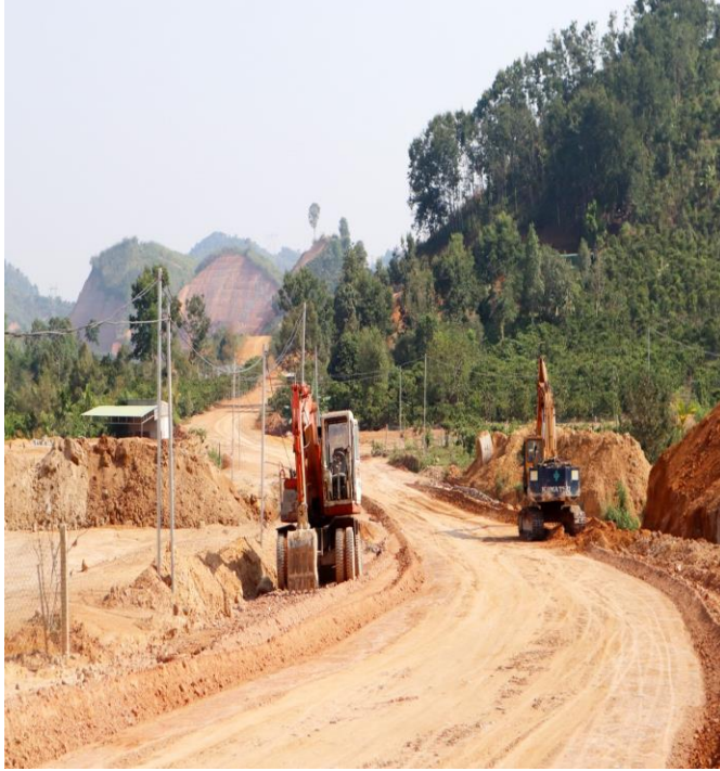
Đẩy nhanh tiến độ thi công đường nội thị Bằng Lăng
