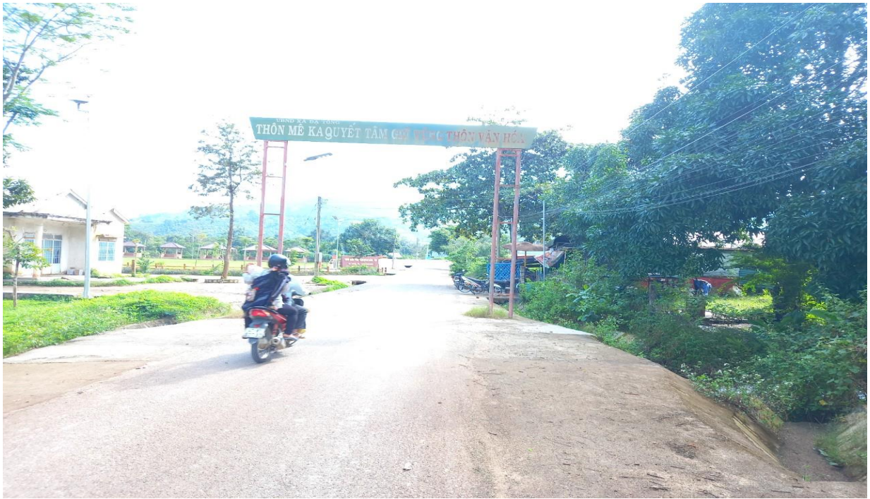
Đường dẫn vào thôn Mê Ka, xã Đạ Tông năm 2024
